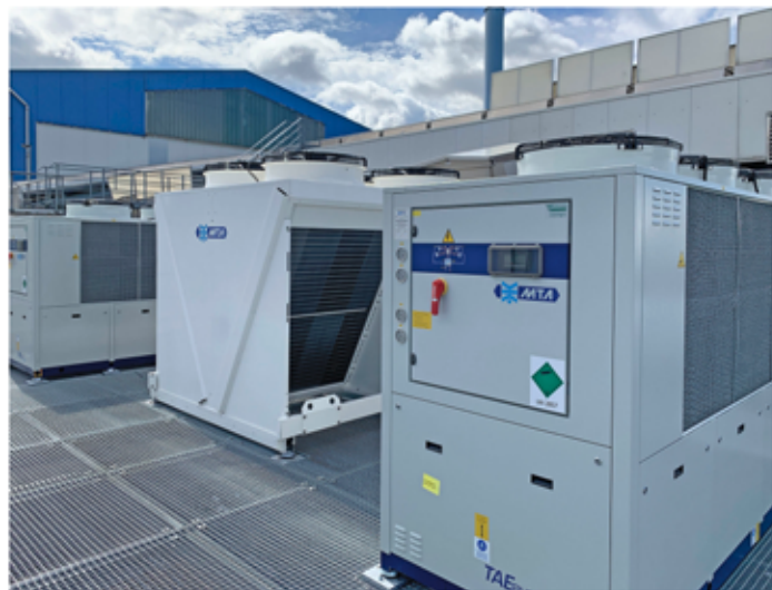
MTA-Kaltwassersätze TAEvo Tech und Freikühlmodul RWD 163 auf einer 10 Meter hoher Stahlbaukonstruktion für optimale Luftzirkulation
