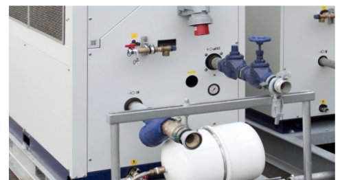
Bauerkupplungen, Regulierventil, Filter, CEE-Anschluss
