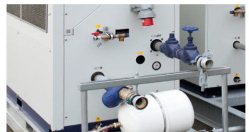
Bauerkupplungen, Regulierventil, Filter, CEE-Anschluss
