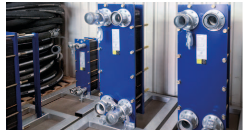
Plattenwärmetauscher zur Systemtrennung
