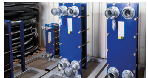
Plattenwärmetauscher zur Systemtrennung
