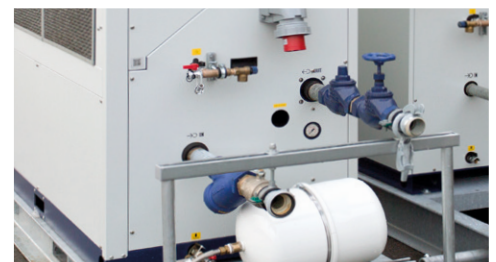
Bauerkupplungen, Regulierventil, Filter, CEE-Anschluss
