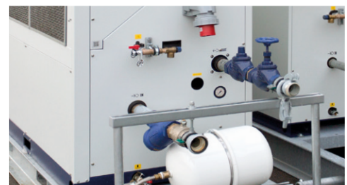
Bauerkupplungen, Regulierventil, Filter, CEE-Anschluss
