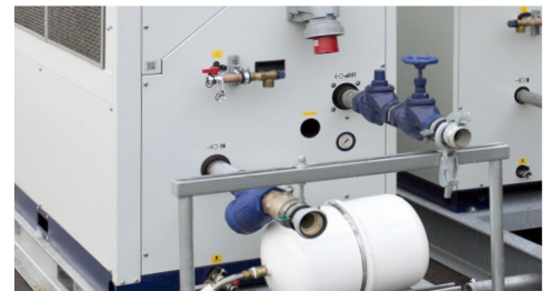
Bauerkupplungen, Regulierventil, Filter, CEE-Anschluss
