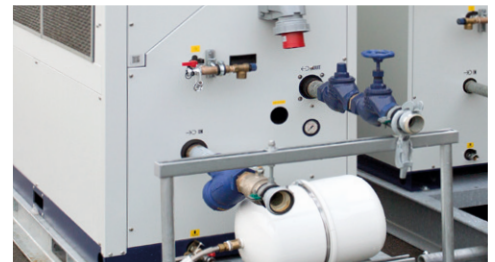
Bauerkupplungen, Regulierventil, Filter, CEE-Anschluss
